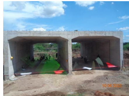
งานท่อระบายน้ำ (Box Culvert)
