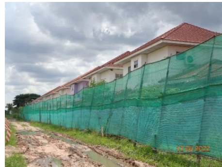
ภาพที่ 2.2-36 การติดตั้งผ้าใบกันฝุ่นบริเวณพื้นที่ก่อสร้าง
