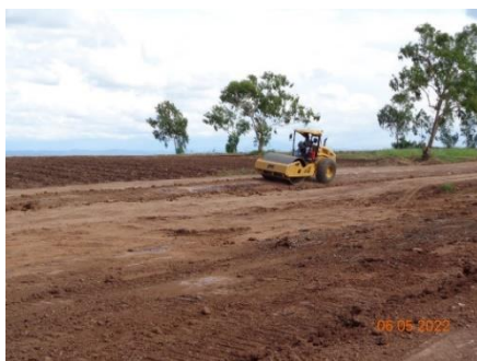
งานถมบดอัดชั้นดินถมงาน Haul Road
