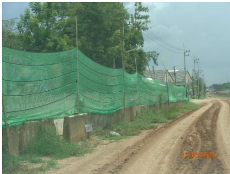
ภาพที่ 2.2-36 การติดตั้งผ้าใบกันฝุ่นบริเวณพื้นที่ก่อสร้าง
