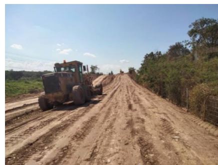
งานถมบดอัดชั้นดินถมงาน Haul Road
