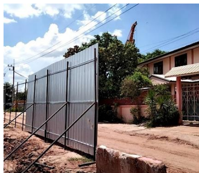
ภาพที่ 2.2-18 การติดตั้งแผ่นกันเสียงชั่วคราว
