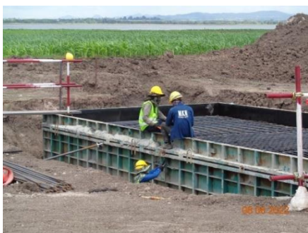
งาน Concrete for Pile Cap
