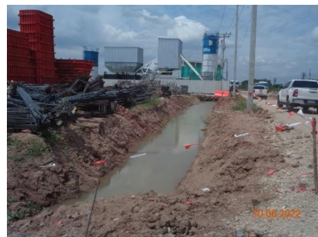
ภาพที่ 2.2-7 วางระบายน้ำชั่วคราวบริเวณพื้นที่ก่อสร้าง
