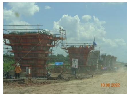
งานเข้าแบบเสาคอนกรีต
